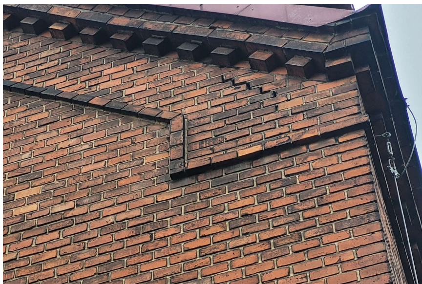
W górnej części elewacji występuje niewielkie spękanie warstwy licowej
